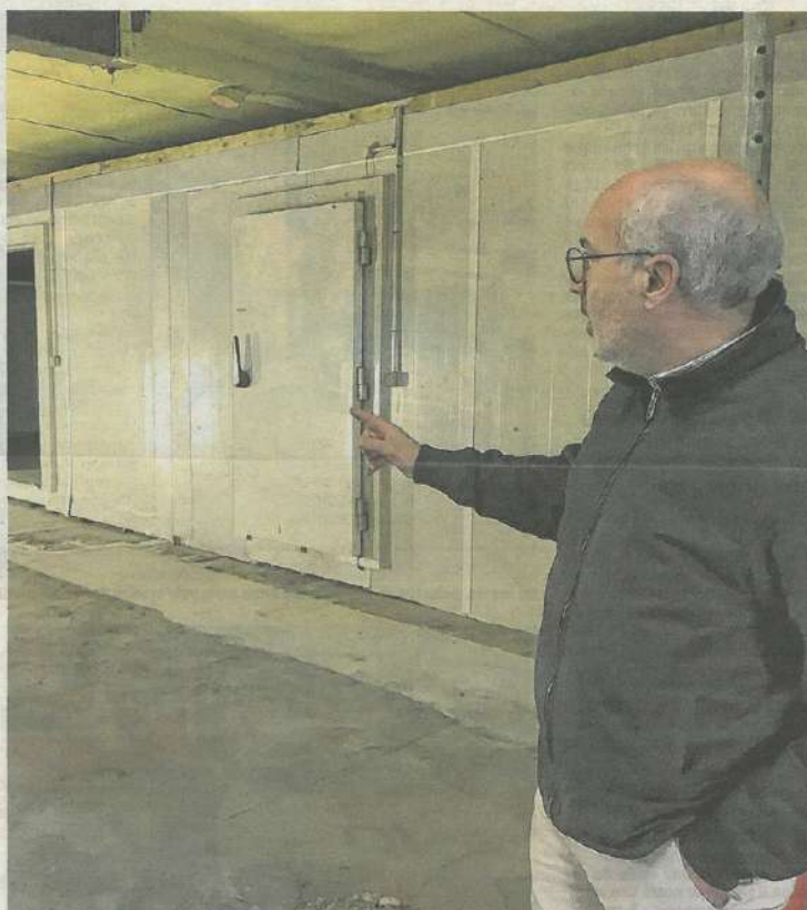
Parmi les travaux, il a notamment fallu aménager un espace réfrigéré.
